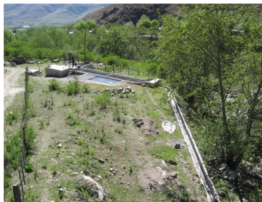
Figura 2-Parte de la red de distribución
